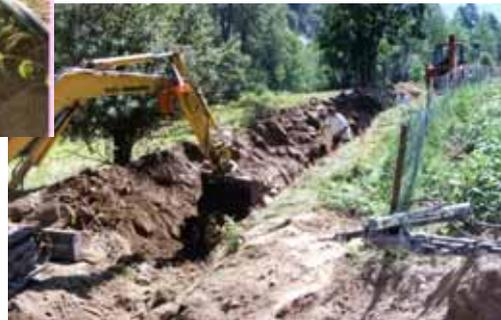
**MISE EN ŒUVRE DES CÂBLES : Pose Mécanisée**
