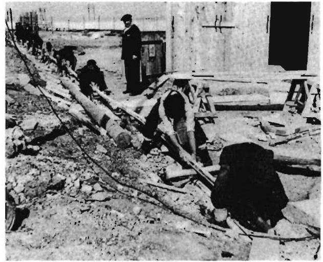
Fig. 2. Pose d'un câble papier 60 kV à imprégnation visqueuse. Fig. 2. Laying of a 60 kV mass impregnated paper insulated cable.
